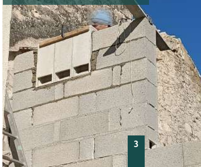
Gîtes à chauves-souris intégrés dans un mur en construction © Nat'H
